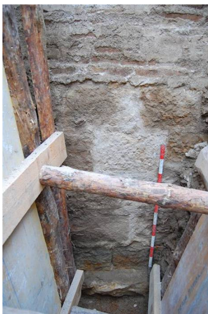
Foto 8. Vista del mur 240 i 114
