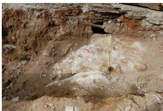
Fotos 23 i 24. Vista del mur del dipòsit comercial, a la foto 3 es pot apreciar com quedava enganxat pel formigó del mur guia.
