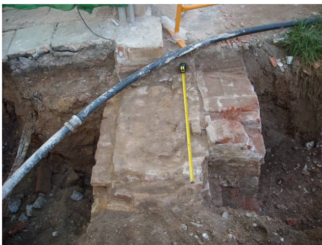
Foto 21. Vista del mur de façana i el reforç de maons.
