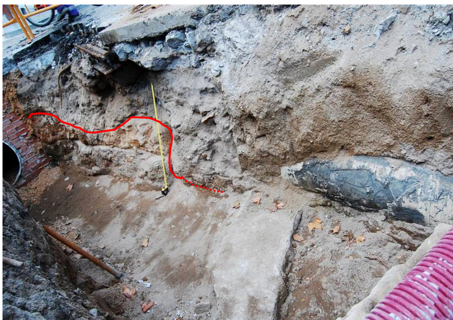
Foto 40. Vista del tall nord de la rasa amb el retall UE 287 realçat en vermell i els estrats retallats UE 284 i 285
