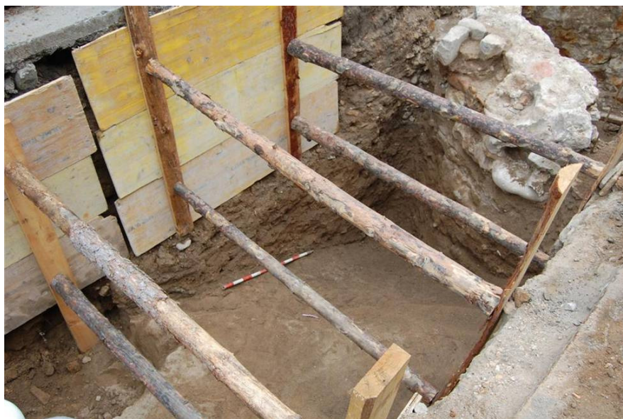
Foto 16. Vista del fossat UE 212, retallat a les sorres. A la part superior el fonament UE 117.
