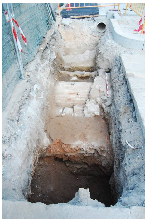
Foto 33. Vista de la rasa C.
