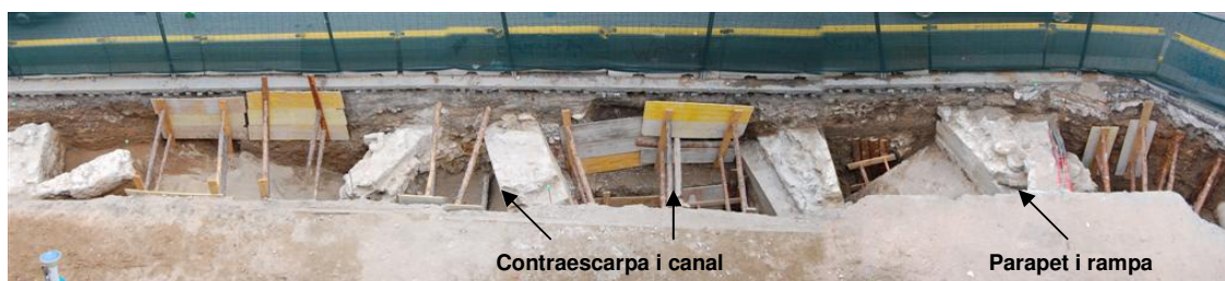
Foto 1. Vista de les principals estructures localitzades a la rasa A
